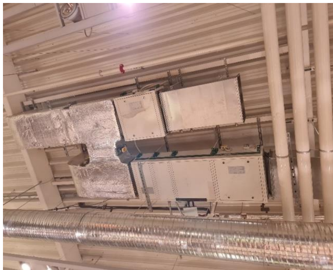
Obrázek 7 Typické uspořádání podstropní vzduchotechniky v OJ
